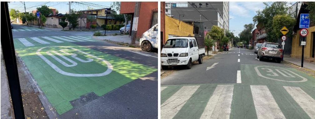
Imagen recepción final proyecto de señalización y demarcación imiv alto buzeta
